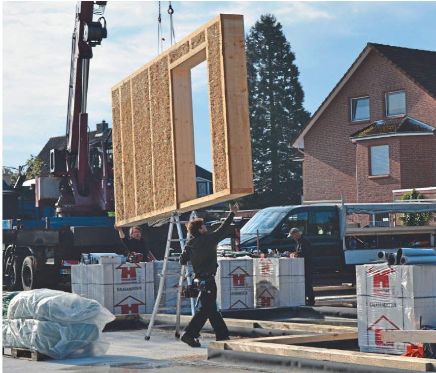
Es geht in die nächste Bauphase: Gegen 8 Uhr morgens werden am vergangenen Dienstag die ersten Wandteile für das genossenschaftliche Wohnprojekt aufgestellt.
